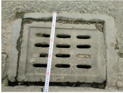
3.垂直的排水口容易造成垃圾的堵塞。
